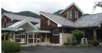
▲跡地活用されている閑馬小学校
