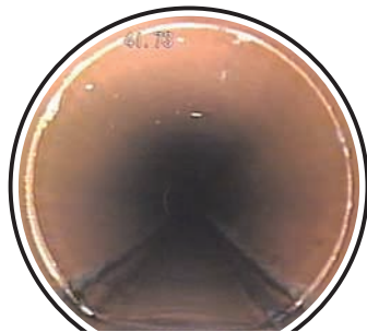
▲正常な「管きょ」
