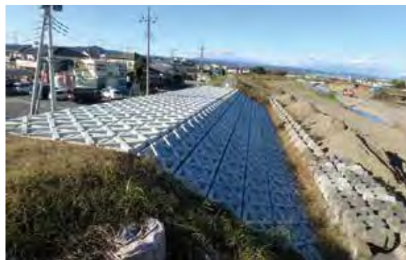
秋山川堤防復旧箇所
