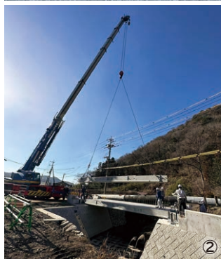
①完成した数枝橋 ②橋げた設置の様子 ③工事着工前の様子
