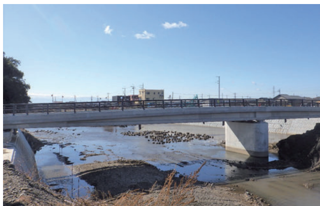
▲復旧完了後の中橋
