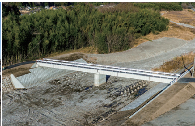
▲復旧完了後の渡戸橋
