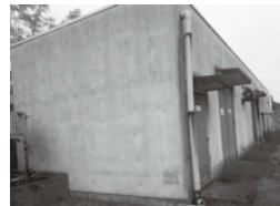
▲元石塚団地下水処理場
