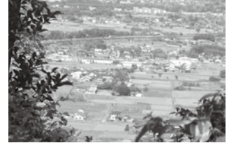
▲木々の間から見える北関東自動車道
