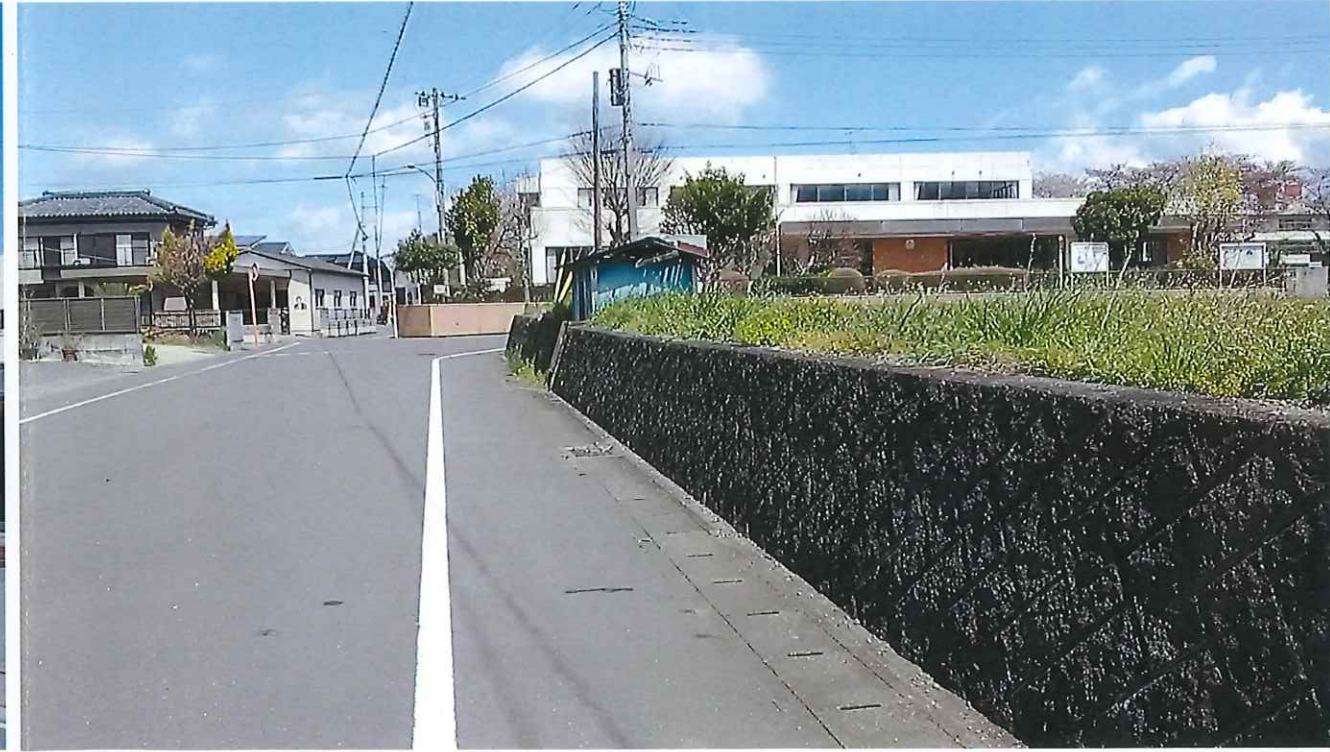
西側擁壁(井戸小屋有り)、南側隣地
