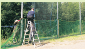
▲外壁ネットの張り替え作業
