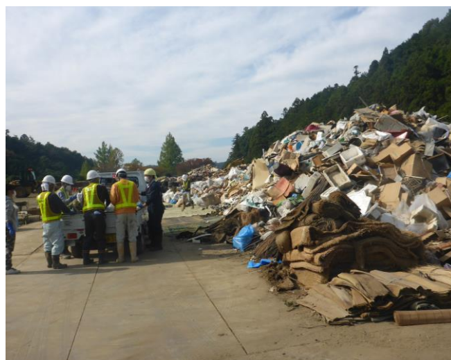
仮置場での災害ごみ搬入の様子 （中運動公園野球場 B・C球場）
