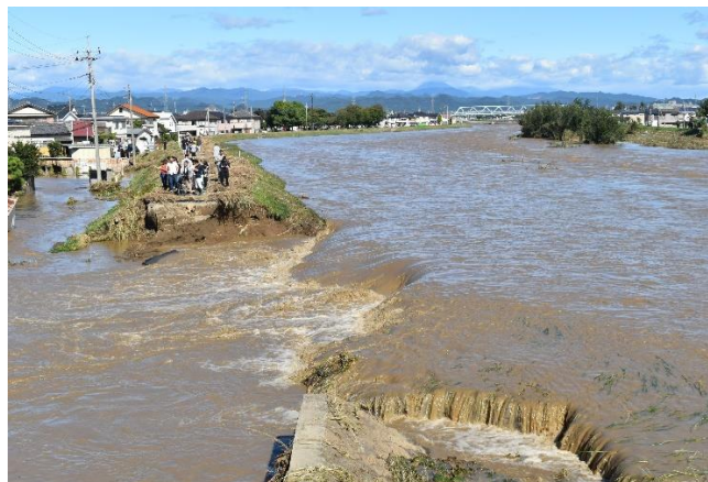
赤坂町（秋山川：海陸橋北決壊箇所） 復旧前
