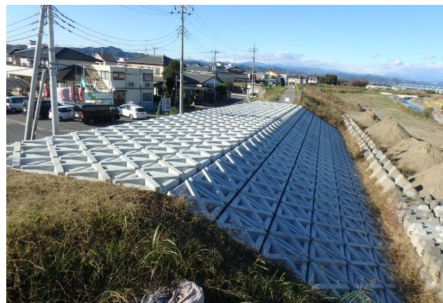
復旧後 (※復旧工事継続中)
