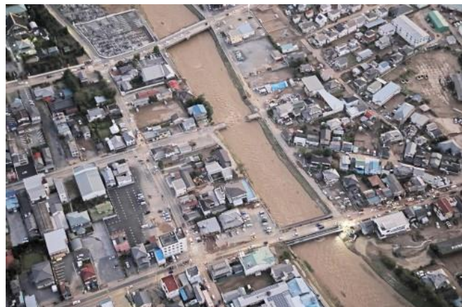
秋山川に架かる大橋、中橋付近（大橋町）
