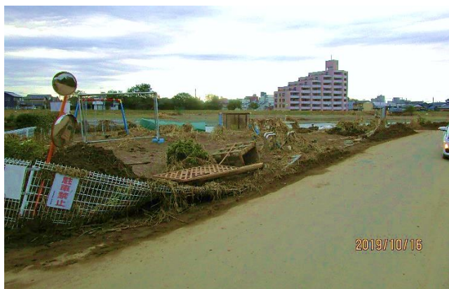
大橋町（上川原東公園：河川氾濫による 土砂堆積・設備破損） 復旧前
