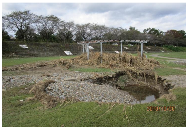
石塚町（旗川石塚緑地右岸：河川氾濫による敷地内洗堀） 復旧前
