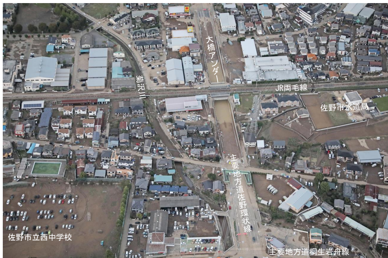
(6) 主要地方道佐野環状線 大橋アンダー付近
