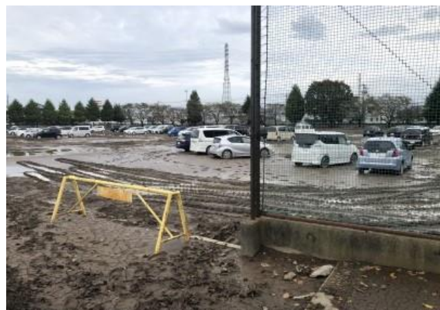
大橋町（西中学校：河川氾濫による土砂堆積） 復旧前
