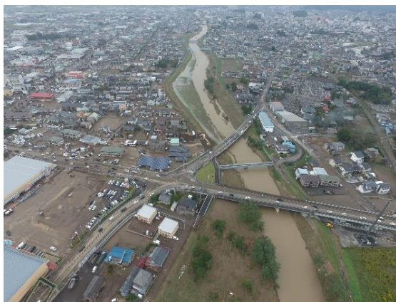
決壊した秋山川 新海陸橋付近 (赤坂町・田島町)
