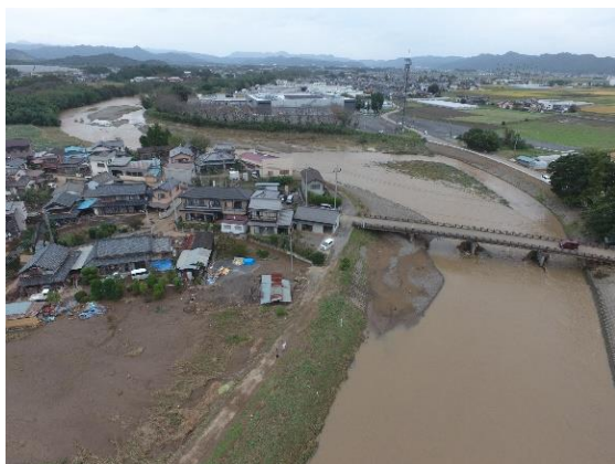
越水した旗川 稲岡橋付近(小中町)
