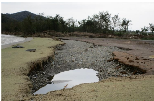
栃本町（秋山川栃本緑地：河川氾濫による敷地内洗堀） 復旧前
