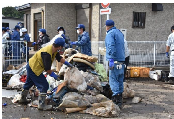
災害ごみ処理支援の様子（中妻公民館）
