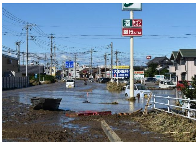
浸水・土砂堆積した県道佐野環状線（赤坂町・田島町）
