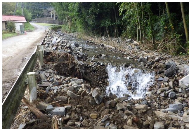
水木町（市道松内線：土石流による土砂堆積） 復旧前
