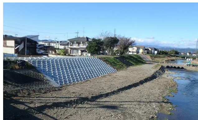
復旧後 (※復旧工事継続中)
