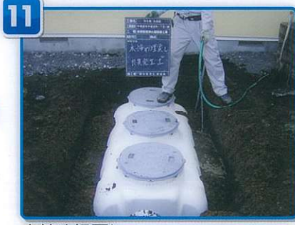
水締め埋戻し
