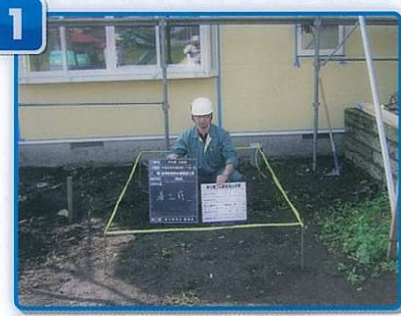
着工前（浄化槽設備士監督）
