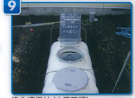
浄化槽据付（水平確認）
