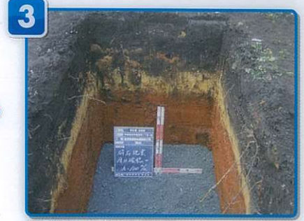
基礎砕石（厚み確認）
