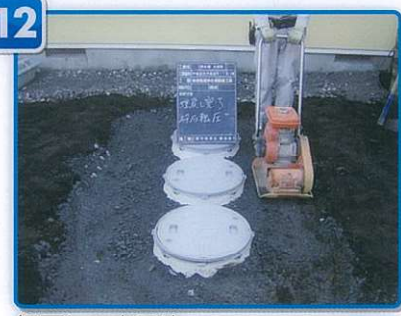
埋戻しつき固め
