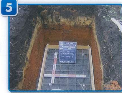
ベースコンクリート（型枠配筋）
