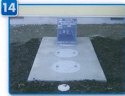
スラブ打設完了
