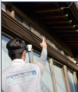
建物外部目視点検
