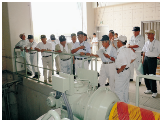
吾妻排水機場内部の様子
