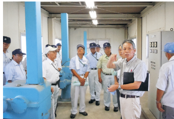
界排水機場内部の様子
