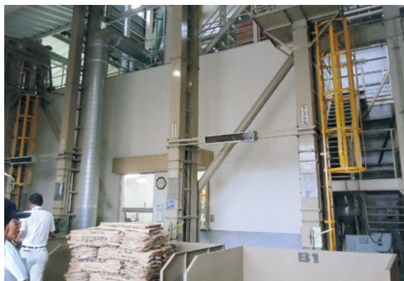
北部ライスセンター内部の様子
