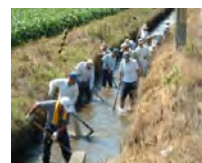
水路の泥上げ
