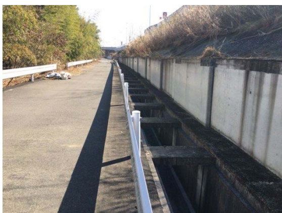
① 北関東自動車道管理水路
