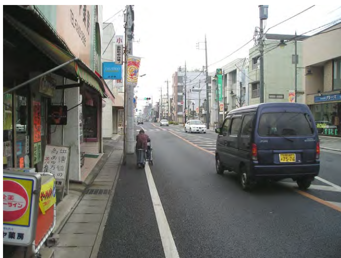
県道桐生岩舟線（工事着手前）
