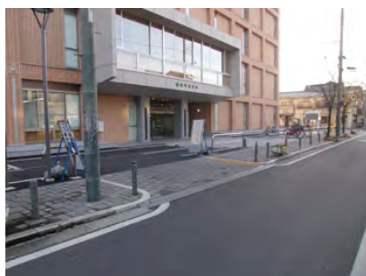
車乗り入れ口。車いすに慣れないと、勾配がきつく感じる。
