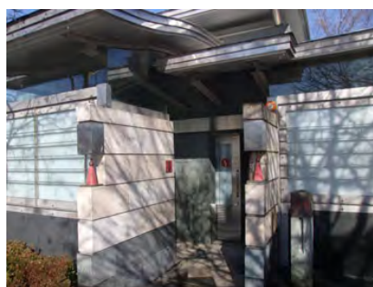
障がい者用トイレの表示が外からは見えない。
