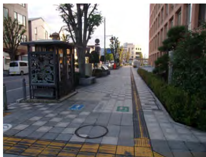
歩道の自転車・歩行者通行区分表示と色のかすれた点字ブロック
