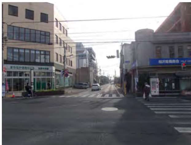
市道 1 級 1 号線（工事着手前）
