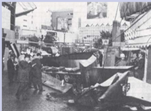
台風で落下した時の様子
