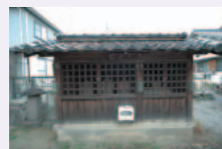
24 まちなかの地藏堂 まちの片隅で、ひたすら洪さを放っている。
