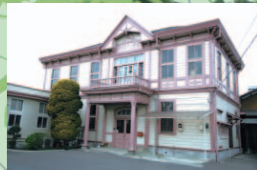
10 影澤医院 ベランダ・車寄せがあり、寄棟瓦葺き、下見板張りの典型的な明治期洋風建築。明治44年築。
