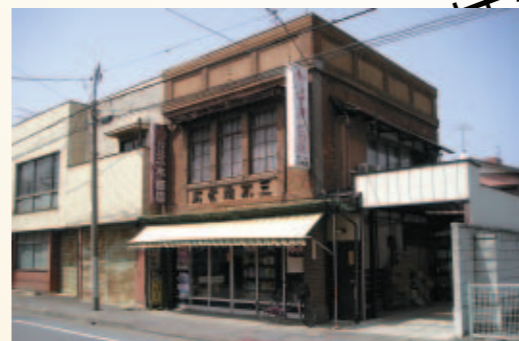
8 三木商店 大正時代に流行した看板建築の典型的な姿がとどめられている。大正10年頃建築。
