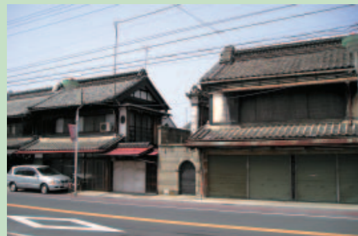
4 旧土佐屋薬局 隣地との間にはうだつと呼ばれる防火壁（財力の象徴）がある。明治3年築。
