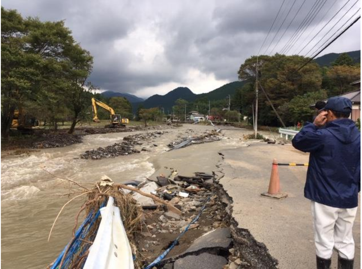
写真 7 令和元(2019)年東日本台風の被害で寸断された道路(水木町)
