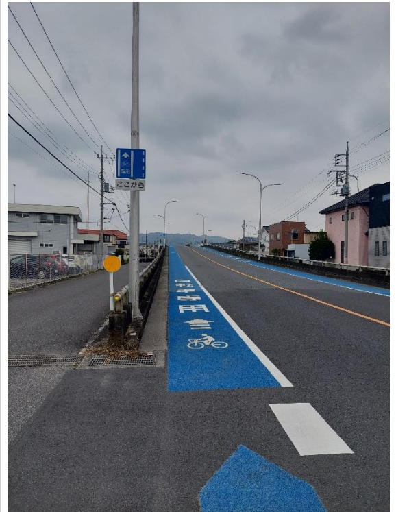
写真1 自転車専用通行帯 (県道75号栃木佐野線)
