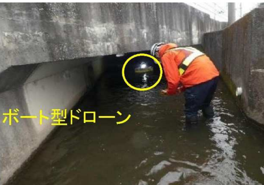
ボート型ドローンによる狭隘空間の点検状況
