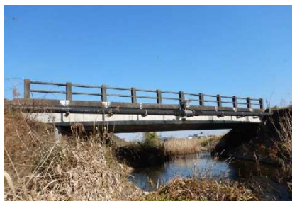
PC 橋の例 旗川 15 号橋
