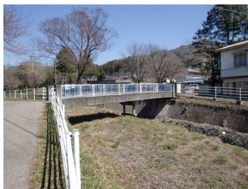
撤去予定の橋梁（廃校のため）
