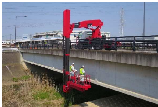
定期点検のイメージ（橋梁点検車）
