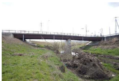
鋼橋の例 犬伏 60 号橋
