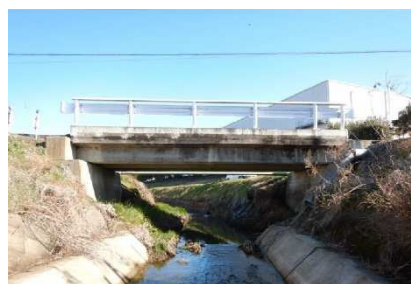
RC 橋の例 吾妻 20 号橋
