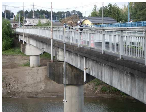
ロボットカメラによる点検状況
