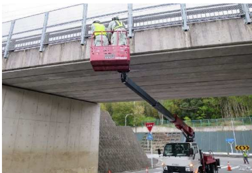
定期点検のイメージ（高所作業車）
