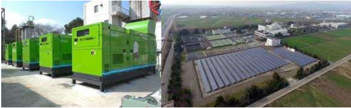
図 2-3 消化ガス発電設備（左）、太陽光発電設備（右）
