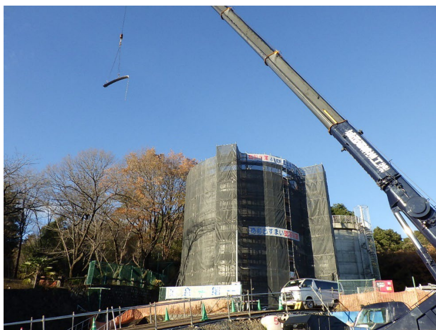
写真 多田配水池更新工事
