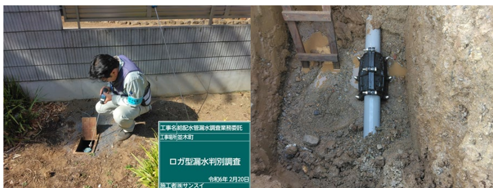
写真 漏水調査・修理の様子
