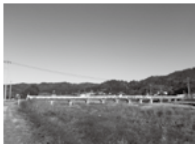
▲ 室の沢橋(船越町)
