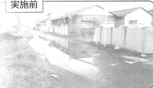
長年懸案であった犬伏幼稚園東側の道路の水溜り対策として「浸透マス」設置による整備を行って頂きました。今後ここの北側と幼稚園西側も同様の整備を行い、地盤が安定後に舗装面の勾配を調整し完了となります。
