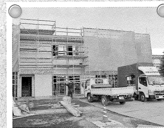
界小学校に建設中
