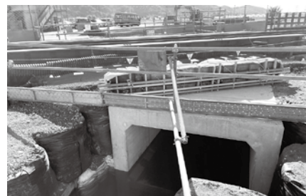
◀ 普通河川菊水川・ボックスカルバート設置後(上流側)
