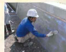
水路壁のコーティング
