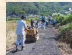
未舗装農道の舗装
