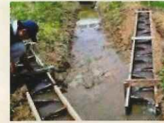
水田魚道の設置
