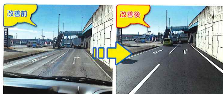
道路（市道）が波うち状態でハンドルを取られてしまうので改善して欲しい。 佐野新都市の交差点に合流する道路が波うち状態となっていて車のハンドルをとられてしまい危ないとのお話がありました。 → 市の道路河川課に要望し施工していただきました。
