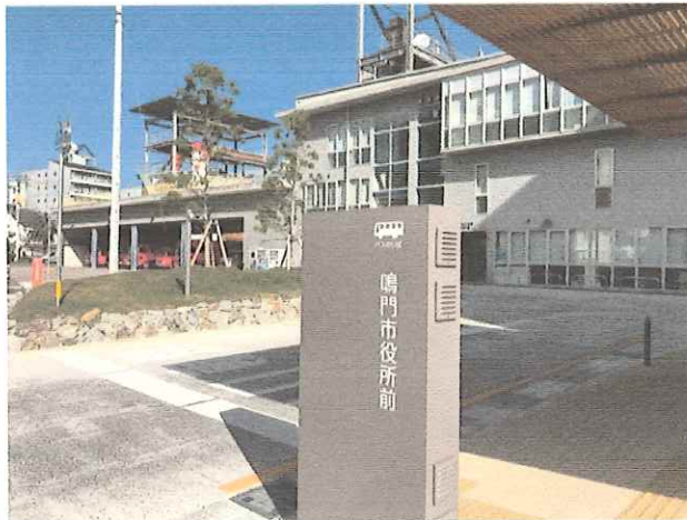
フェーズフリーの概念に沿った新庁舎と隣接する消防本部。かさあげされた市庁舎の前入り口脇のスペースには、消防本部の緊急車両が待避できるスロープも。
