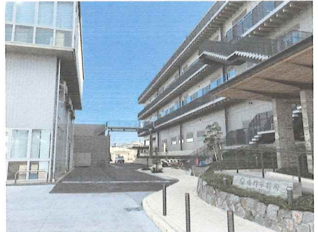
市庁舎には3階まで開放された外階段と廊下が。南海トラフ地震の際には直ぐに駆け上がれる。
