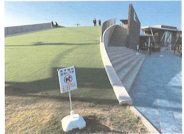
屋上へのスロープ。歩いて上られるよう緩やかに。普段はそり遊びなどの子どもたちで賑わっているとのこと。
