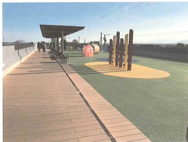
フェーズフリーを盛り込んだ防災計画に沿って建設された道の駅「くるくるなると」は、屋上の遊び場が災害時には1,100人が一時避難できるスペースに。
