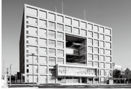
平成27年(2015年)に 完成した佐野市役所庁舎
