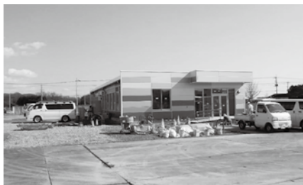
▲ インランドポート(管理棟)の工事現場
