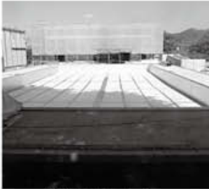
▲建設中のプール (田沼西地区小中一貫校)
