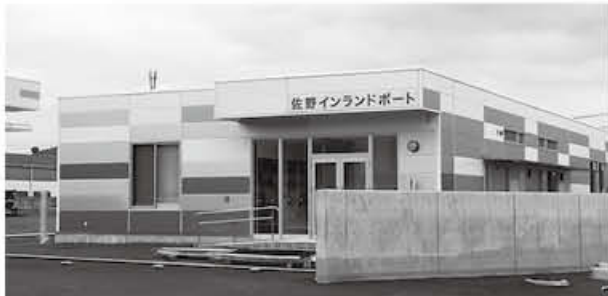
▲ インランドポート(管理棟)
