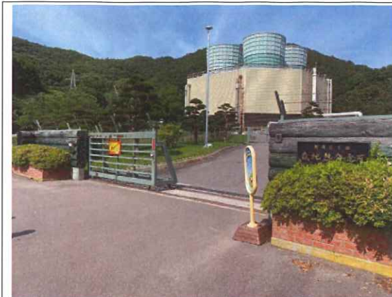
・地熱発電所
