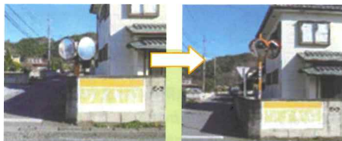
老朽化したカーブミラーの改修依頼
