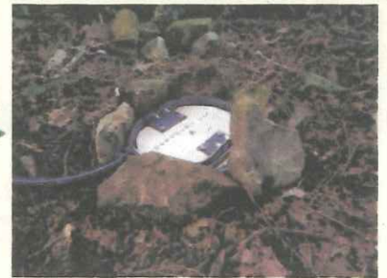
③ 塩ビ管の上に踏み板をセット
