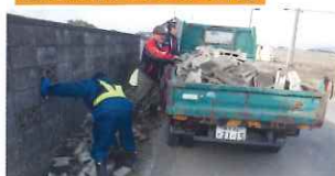
船津川町ブロック塀の片付
