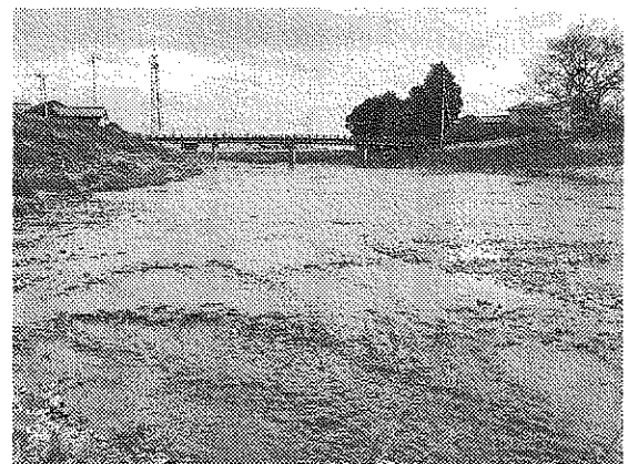
稲岡橋下流土砂撤去後
