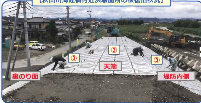
【秋山川海陸橋付近決壊箇所の仮復旧状況】
