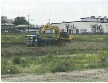
秋山川の堆積土除去工事
