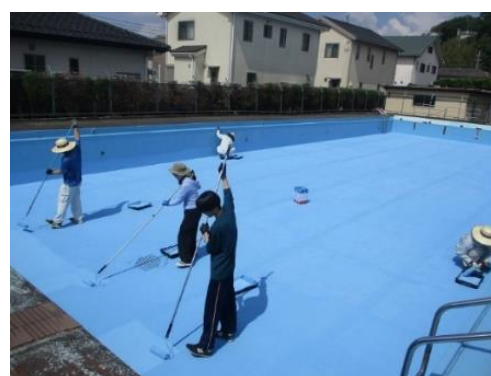
学校施設(プール)の修繕
