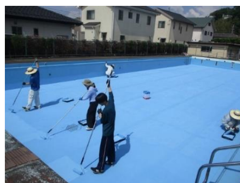
学校施設(プール)の修繕
