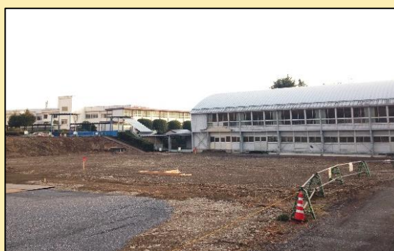
新体育館建設エリア（プール跡地）
