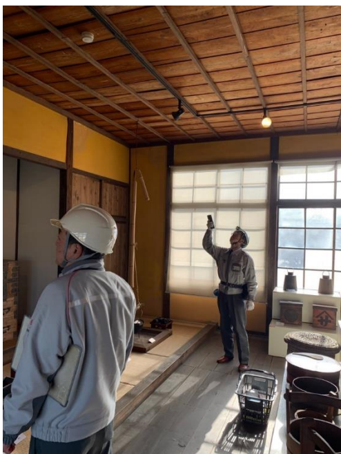
防火査察(電気設備の点検)の様子
