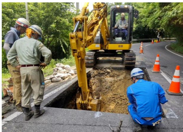
既設電線埋設に伴う立会(令和6年7月2日)
