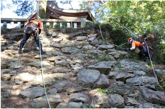
高所ロープ作業員による石垣清掃(高石垣)
