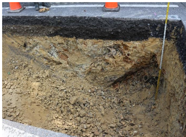
電線埋設箇所土層断面【西から東】(令和6年7月2日)
