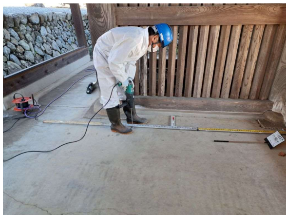
コンクリート床に穴を穿孔する様子
