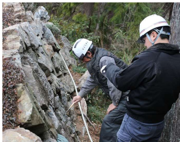
石工による石垣調査
