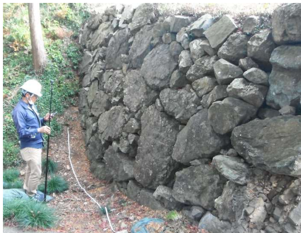
石垣簡易オルソ画像作成用写真の撮影
