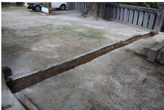
新規掘削箇所全景(南西から北東)
