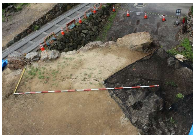
石垣 No30.上面に発生した亀裂(6月19日時点)
