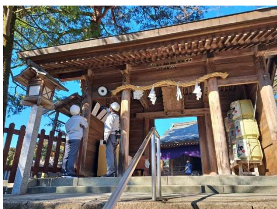
電気保守点検の様子
