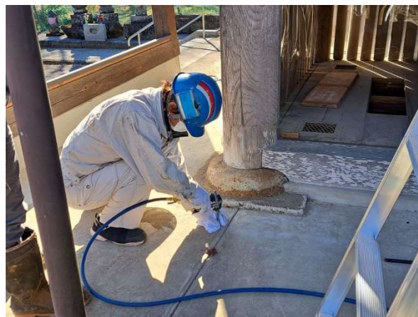
穿孔した穴に白蟻防除の薬剤注入する様子
