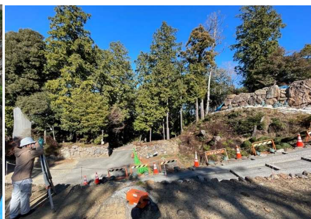
動態観測状況(トータルステーションによる計測)
