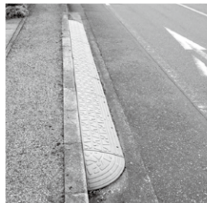
違法に設置された段差解消ステップ
