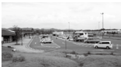
スマートインターチェンジが設置される出流原PA
