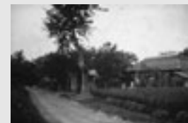
大正初期の地蔵堂(堀米町)
