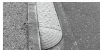
違法に設置された 段差解消ステップ
