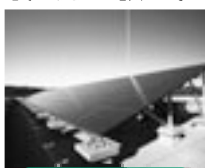
太陽光発電システム
