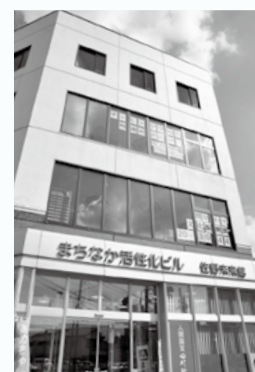
まちなか活性化ビル 「佐野未来館」(高砂町)
